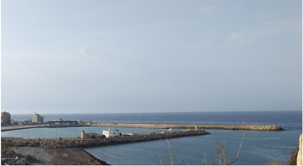
شكل (4) حوض ميناء درنة البحري بتاريخ 2021/5/5
