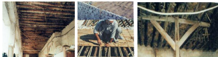
شكل (19) اعمال ترميم البرجيل والأسقف. المصدر: (المرجع السابق)،
